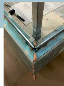
**paso 3** - Una vez colocados los termoblokes del forjado sanitario transitable, y habiendo dejado las tomas para conectar, (residuales, pluviales, luz, agua sanitaria etc) procedemos a colocar los pilares estructurales y sobre estos las vigas perimetrales de forjado de planta o cubierta, según sea una sola planta o varias, y sobre las vigas perimetrales y centrales procedemos a colocar las viguetas para el forjado de planta con termoblokes.
